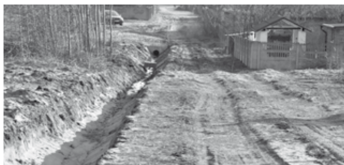
W 2012 roku kontynuowane są prace przy odwodnieniu gminy
