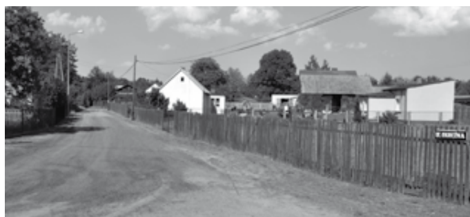
Wiele dróg uzupełniono tłuczniami, bądź frezem.
