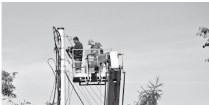
Lampy zmieniane są na nowe i energooszczędne, z rtęciowych na sodowe, oszczędniejsze o ok. 30%.
